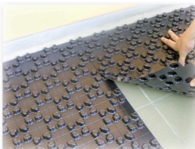
La sovrapposizione dei pannelli sui due lati è facilitata grazie alla tecnica push button che consente una posa rapida e precisa.
