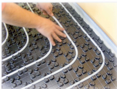
Incastrare il tubo Pe-xa da Ø 10 mm tra le nocche del pannello
