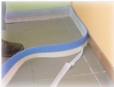
Fissare la fascia perimetrale attraverso il foglio adesivo lungo le pareti, le colonne e i gradini.
