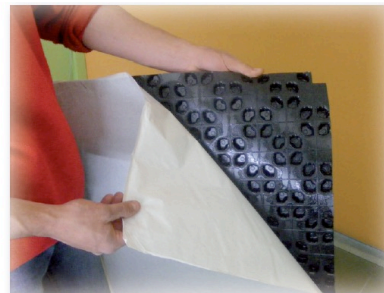
Rimuovere la pellicola di protezione sul retro del pannello Ultraslim prima della posa a terra.
