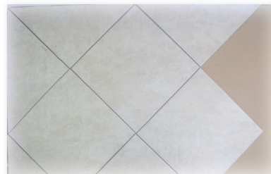
Mescolare il preparato autolivellante secondo le istruzioni del fabbricante e distribuirlo equamente con un adeguato strumento (spatola levigante, rullo di plastica ecc.) fino a quando il minimo spessore di copertura è raggiunto. Prima di posare la pavimentazione, il collante elastico deve essere riscaldato secondo le istruzioni del fabbricante, mentre il massetto deve aver raggiunto la maturità necessaria per essere coperto.
