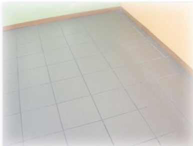
Pulire il sottofondo esistente da sporco e polvere.
